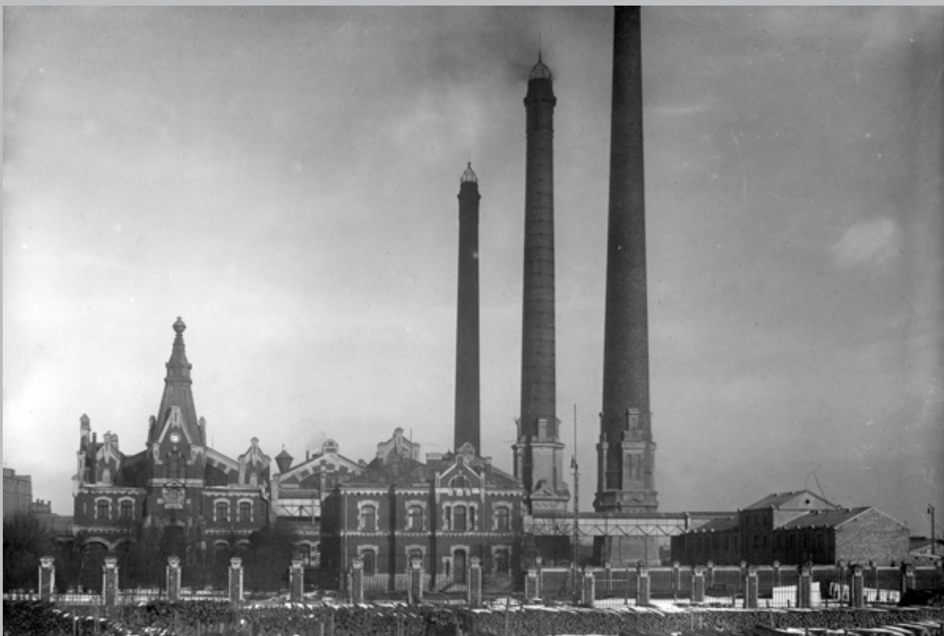
Skats uz spēkstacijas kompleksu no dienvidu puses. Foto: V. Rīdzenieks
