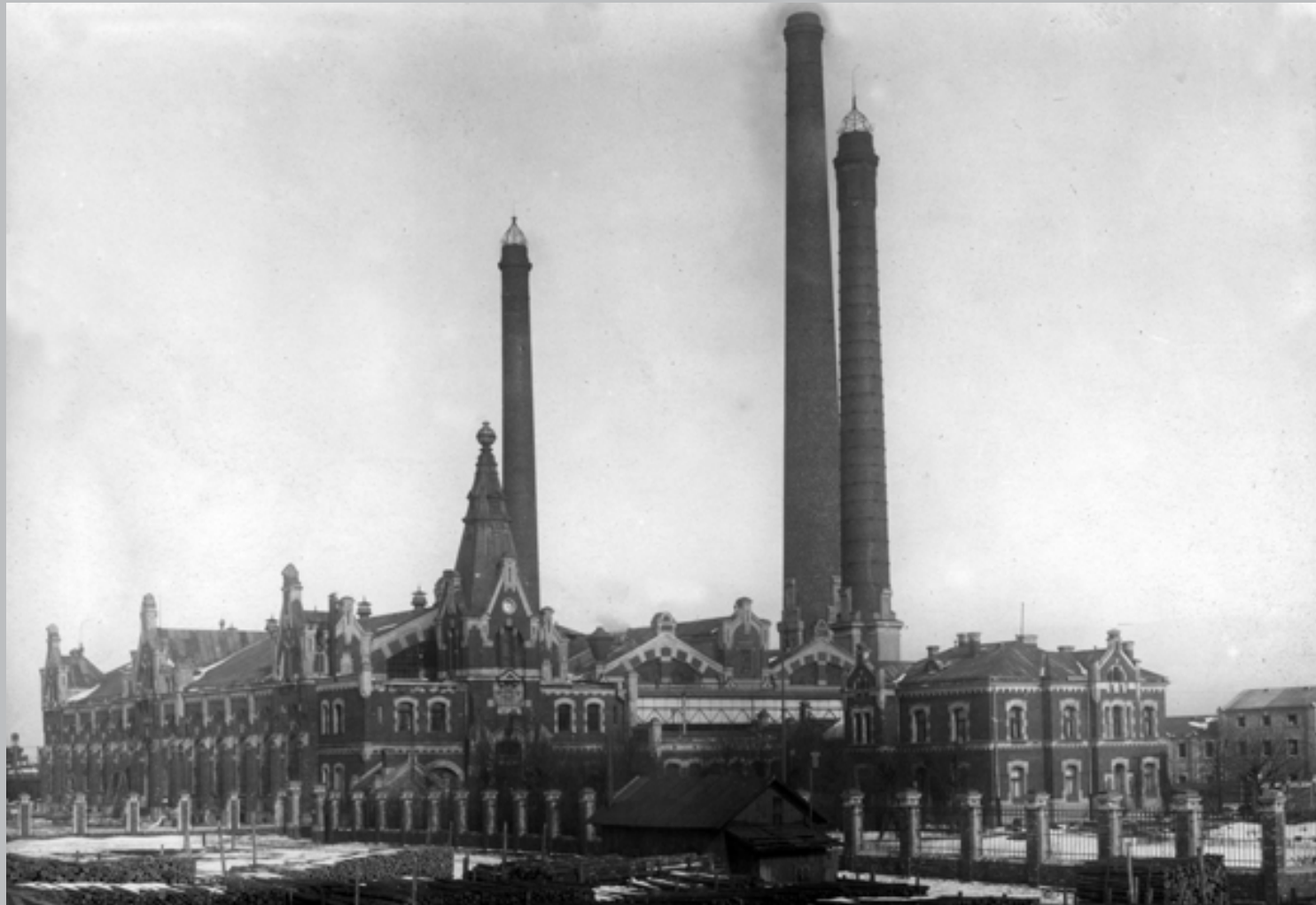
Spēkstacijas komplekss Andrejsalā. Foto: V. Rīdzenieks
