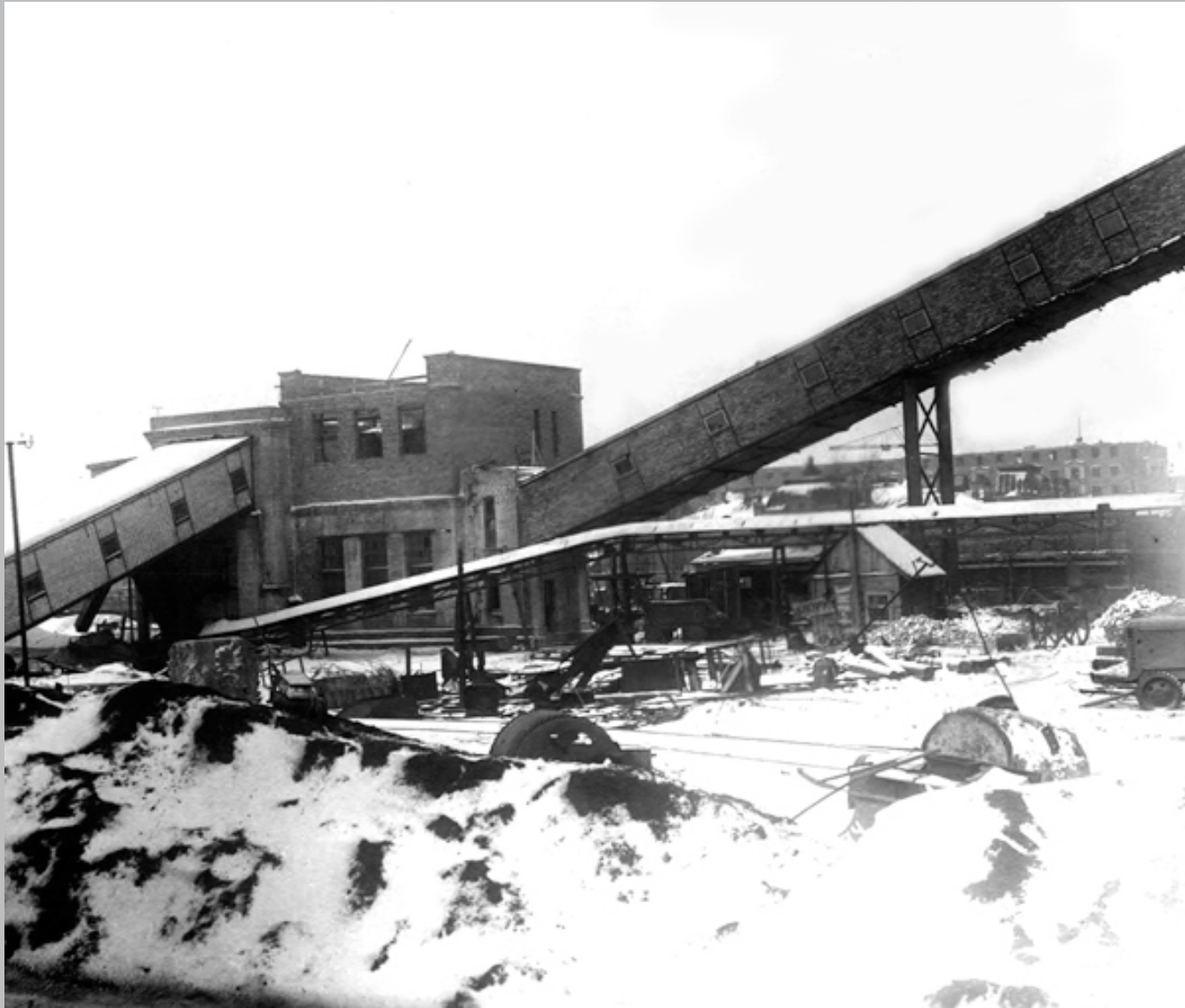
Elektrostacija rekonstrukcijas laikā. Avots: EM
