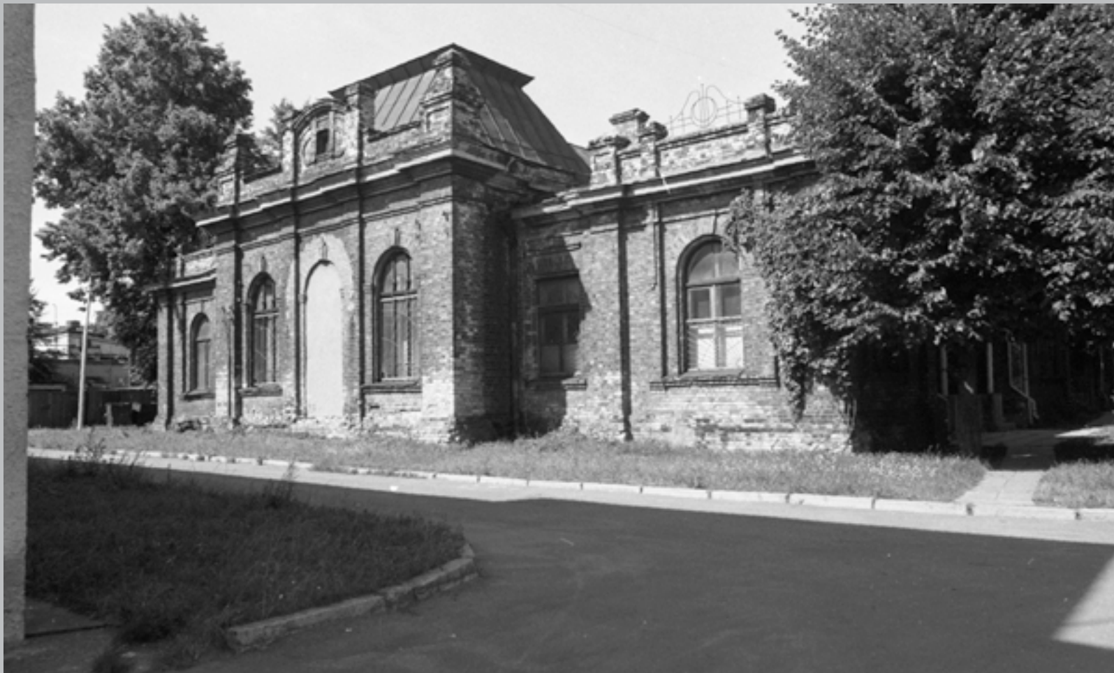
1900. gadā būvētā Rīgas-Krasta dzelzceļa stacijas administratīvā ēka pirms rekonstrukcijas XX gs. 80. gados. Avots: LDzM
