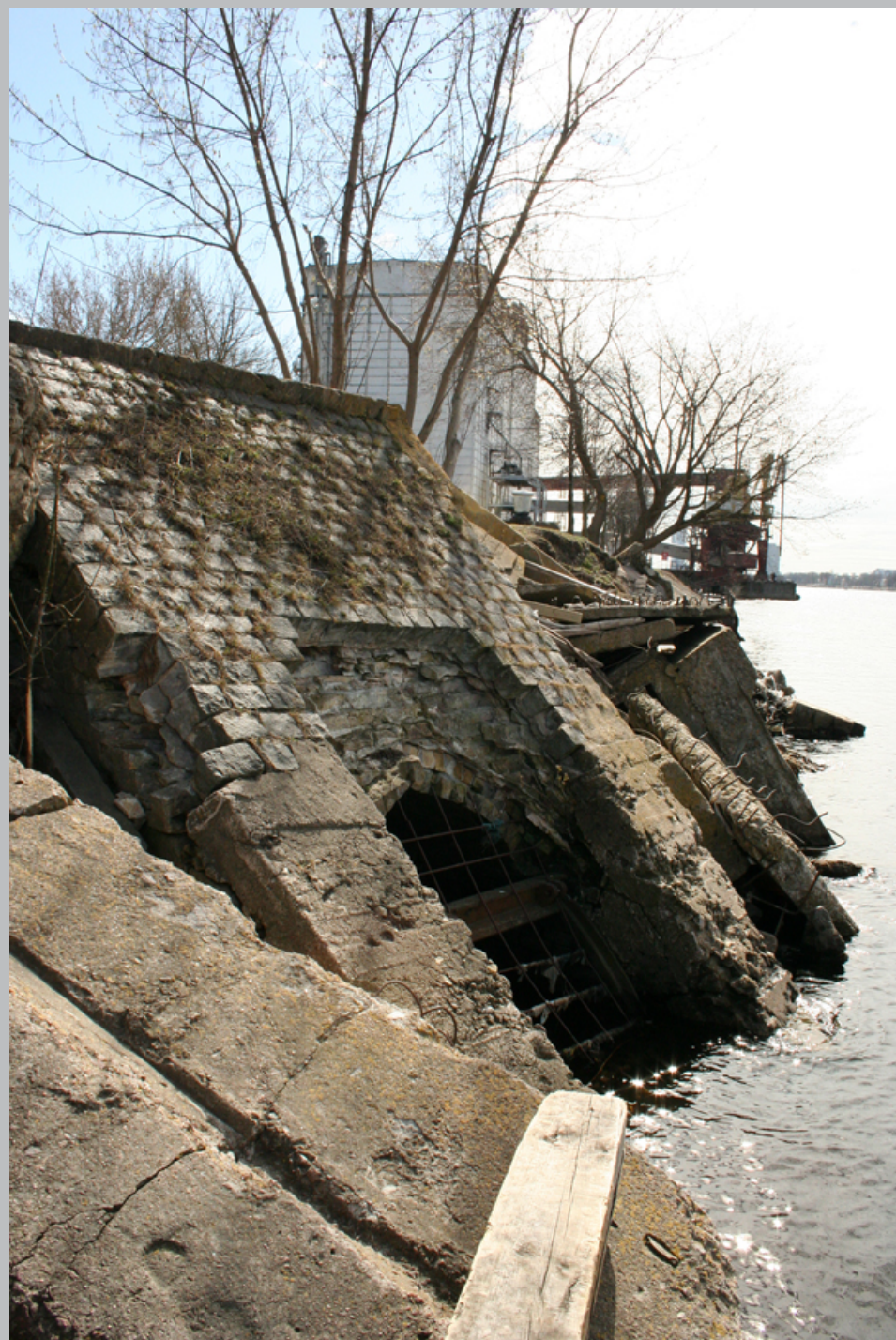
Vēsturiskā notekūdeņu kolektora izvads Daugavā pie elevatora 2007. gadā. Avots: JAU
